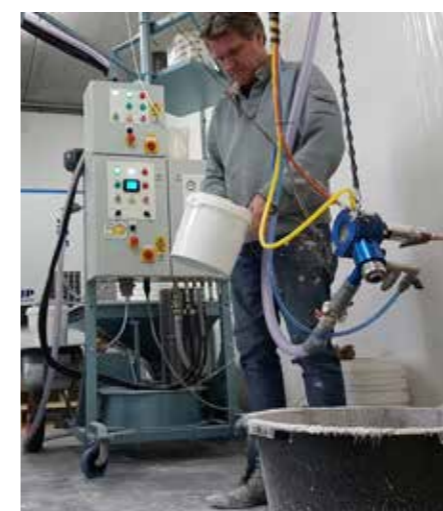
Pulvérisation avec des fibres hachées
