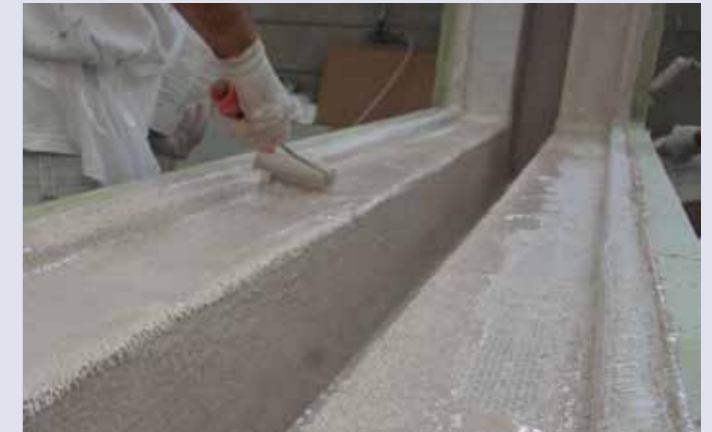
Pour stratifier, il faut mettre une couche humide sur une autre couche humide. Un moyen rapide d'appliquer A1 est d'utiliser un pinceau ou un rouleau.
