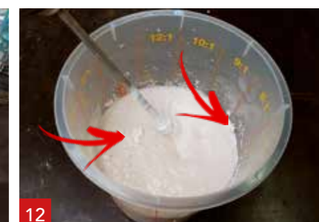
12 Remuez au malaxeur jusqu'à ce que tous les grumeaux aient disparu (± 1 min.) résultant en un matériau lisse.
