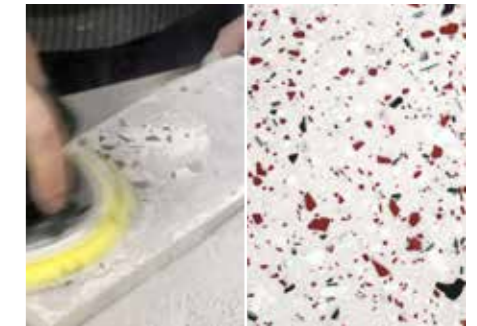
Poncez après la démoulage.
