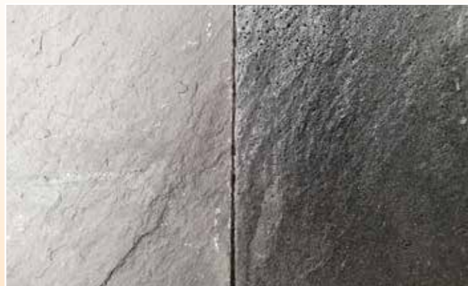
Panneau A1 directement après démoulage.
