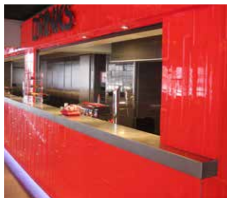
Kool - Ahoy Rotterdam - powłoka epoksydowa 2K
