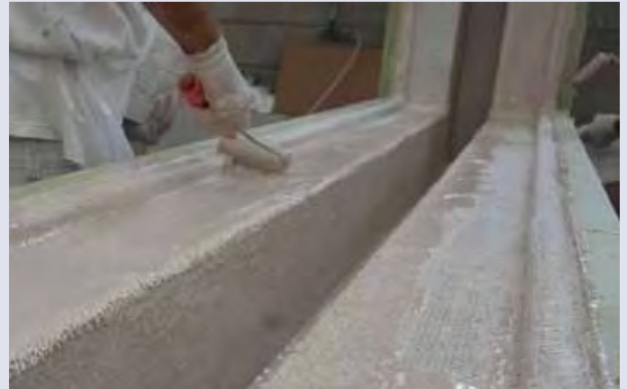
Для ламінування потрібно працювати «вологим по вологому». Швидкий спосіб нанесення А1 – пензлем або валиком.
